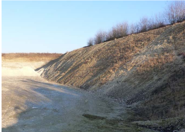
Exemple de front taluté à 45°
